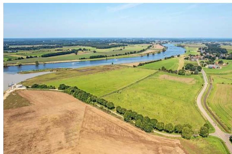
Der Hochwasserschutz stand im Entwicklungsprojekt des Maaspark Well im Vordergrund.
